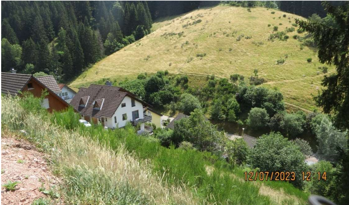
Abb. 6: Blick auf die Maßnahmenfläche von oben, aus nordwestlicher Richtung. Die Maßnahmenfläche ist von zwei Seiten (Osten und Süden) von Häusern umbaut.
